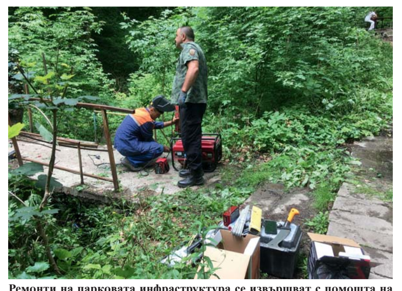
Ремонти на парковата инфраструктура се извършват с помощта на доброволци
