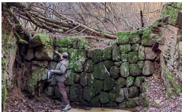
Един от старите баражи и правилният бетонов бараж, изграден през 2020 г.
